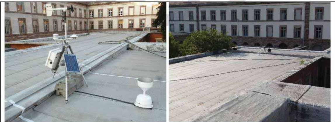
Figure 3 : Photos de l'installation de la station météorologique sur le toit de la Manufacture en 2021
